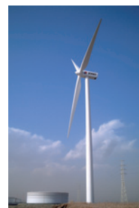
風力発電設備(鹿島製油所)
