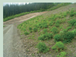
覆土により植物が生育できる環境となった廃さい堆積場
