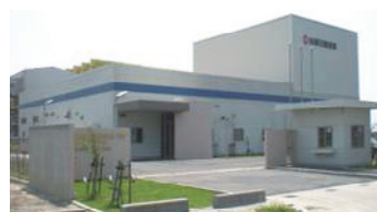
台湾日鉱金属の彰濱 リサイクルセンター
