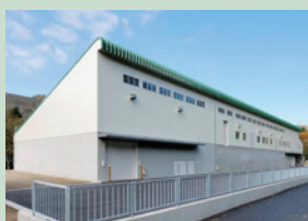
おしどり廃水処理設備外観
