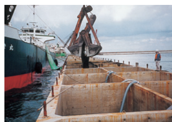
ケーソン※に充填中の銅スラグ
